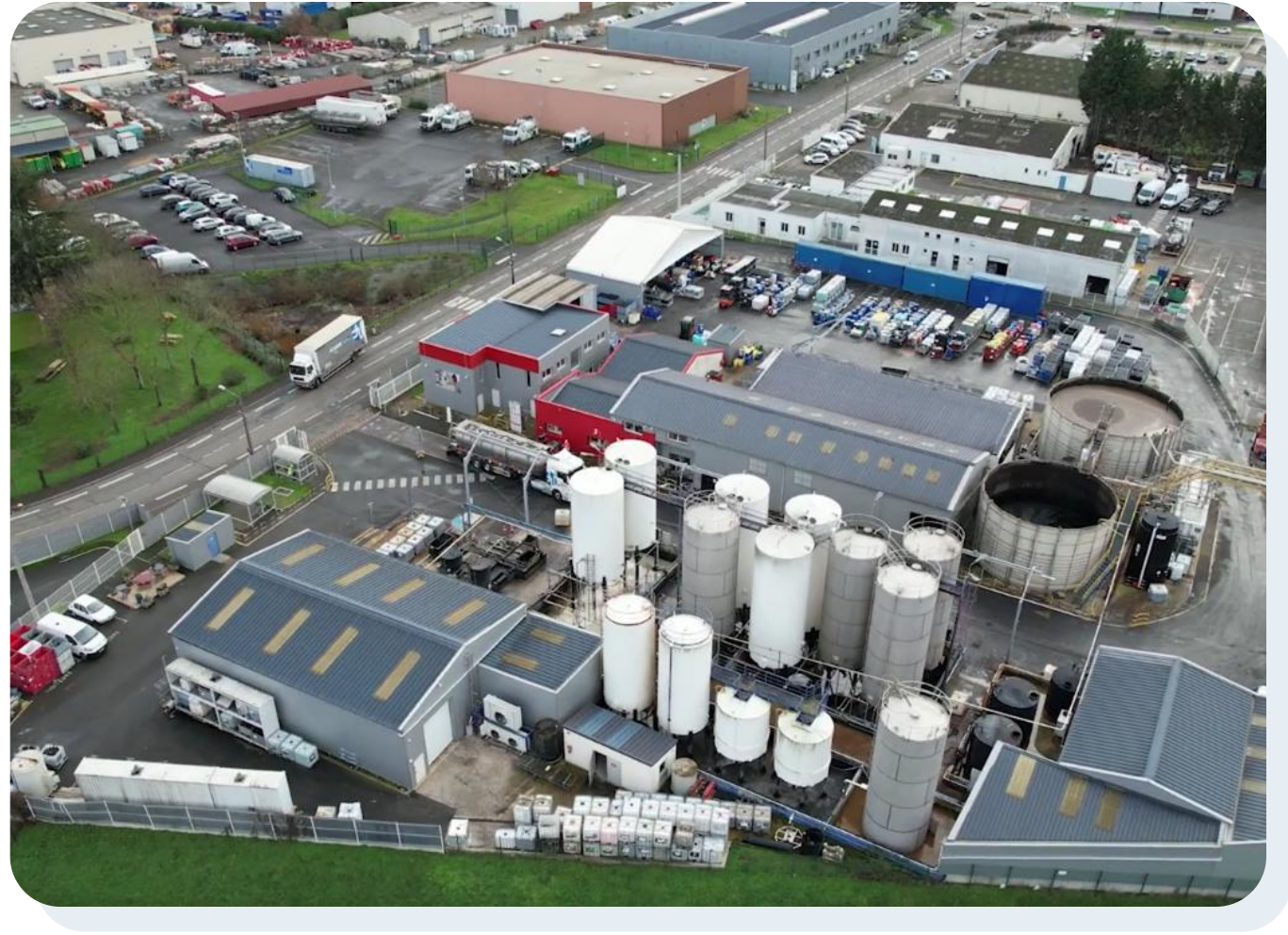
Vue aérienne du site industriel SOTREMO - Le Mans
